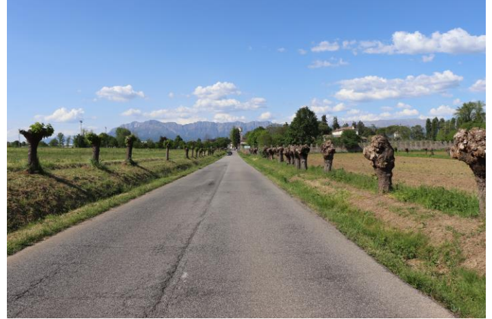
Fig. 8. Laipacco. Tratto di via San Giuseppe a nord-ovest della loc. Morena. Il rettilineo è lungo circa 1 km. Ripresa da sud.
