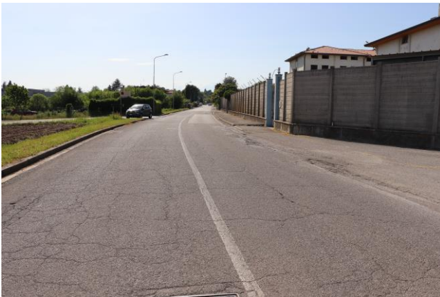
Fig. 9. Tricesimo. Tratto di via San Giorgio a ridosso della Caserma Sante Patussi. Il rettilineo prosegue su via Borgo Agosto in Comune di Reana del Rojale.
