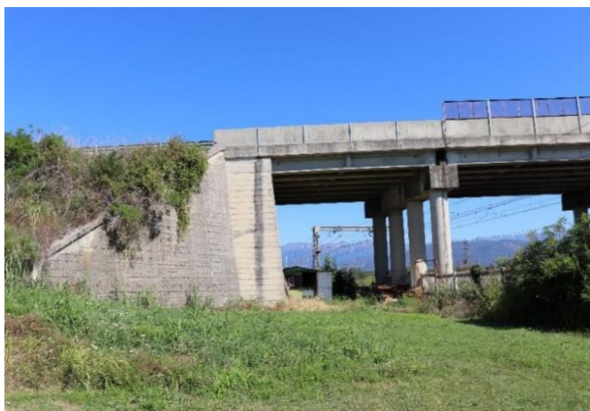
Fig. 1. L'area del sottopasso ripresa da sud-ovest
