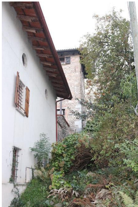
Da sx: Fig. 1. Foto dello stemma sul portone d'ingresso; Fig. 2. Ripresa della torre restaurata da est e delle pertinenze della casaforte.
