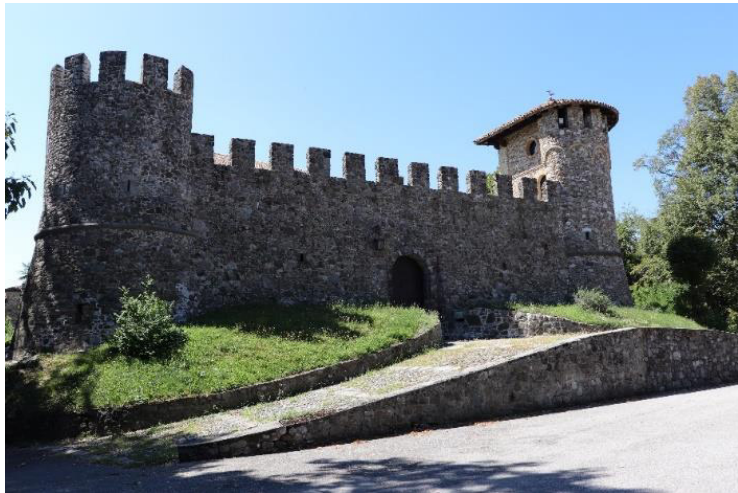
Fig. 4. La facciata del castello ripresa da nord-est
