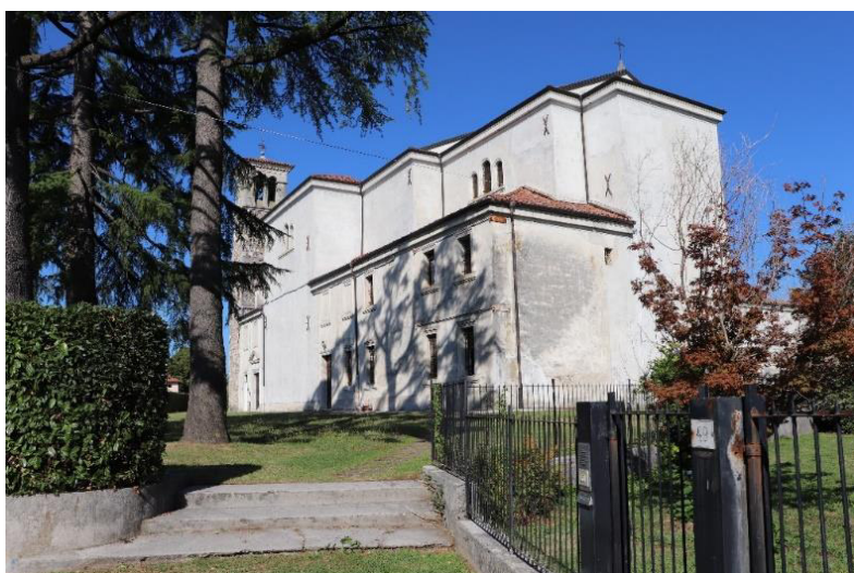
Fig. 4. Il rialzo su cui insiste la chiesa ripreso da sud-est.
