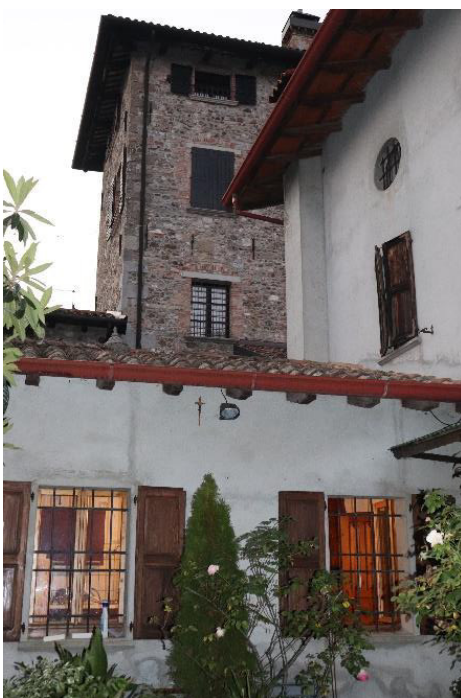
Da sx: Figg. 3-4. Riprese della torre restaurata da est e delle pertinenze della casaforte.
