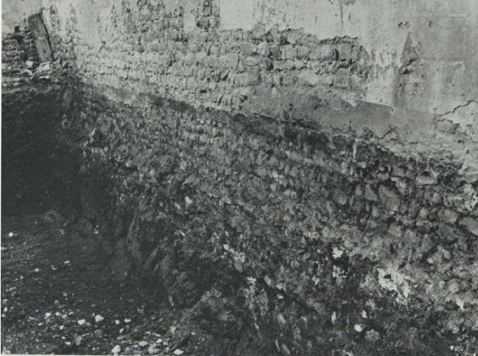
Fig. 3. Le fondazioni su cui risultano impostati gli alzati messe in luce nella seconda metà del XX secolo.
