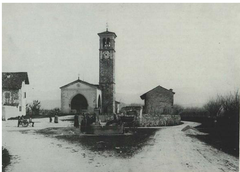
Fig. 2. Il campanile del 1747; sulla dx, è visibile un edificio forse impostato sulla vecchia canipa, adibito nel XX secolo a caseificio.
