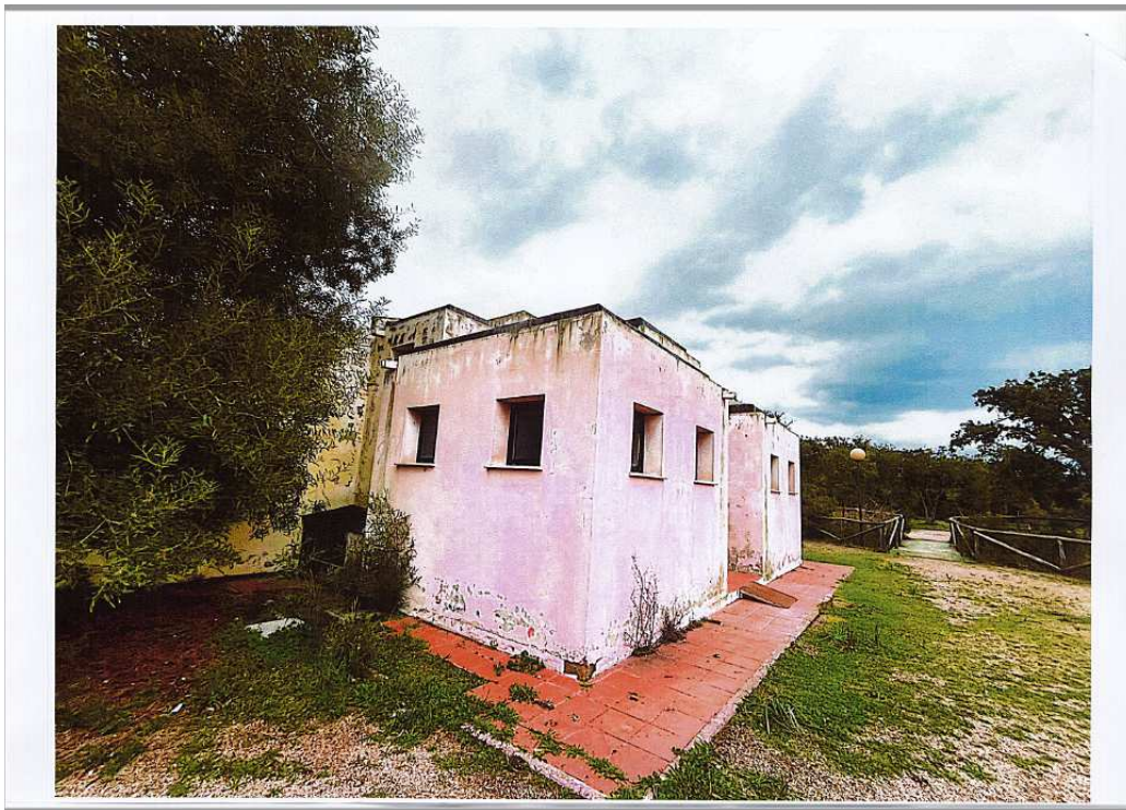
Prospetto esterno fabbricato ex bar-pizzeria
