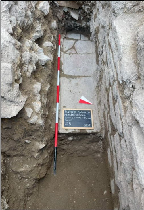
Fig. 11. Todi (PG). Piazza del Mercato Vecchio. Fondo in tegole della canalizzazione ipogea US3 (foto di A. Peppucci).
