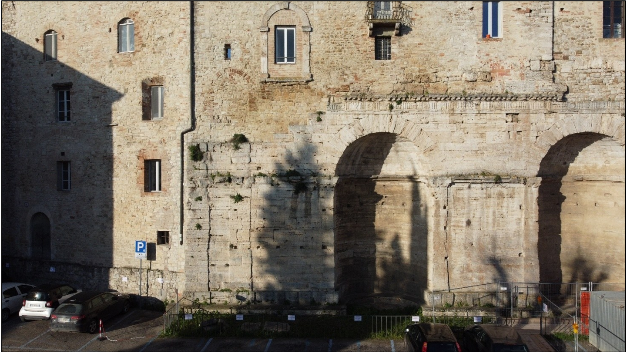
Fig. 14. Todi (PG). Piazza del Mercato Vecchio. Nicchioni romani, foto da drone della porzione meridionale (foto di A. Peppucci)
