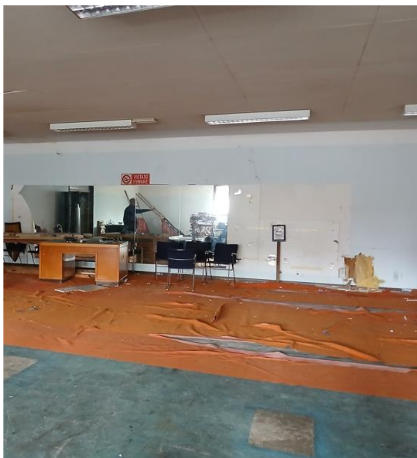
Foto n. 4 – Vista interna piano terra
