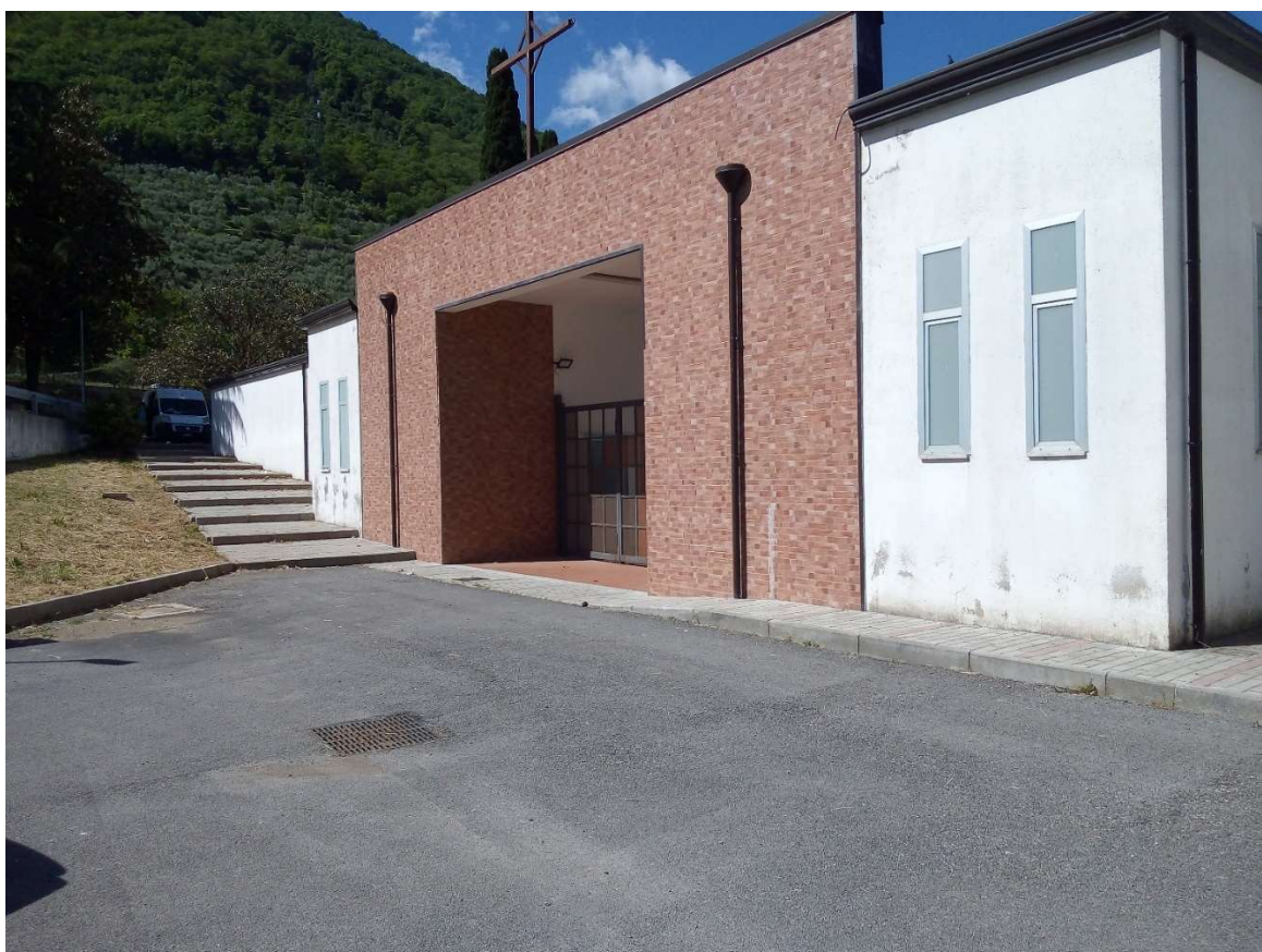
Ingresso CIMITERO CAPOLUOGO SOLOFRA II° Ampliamento
