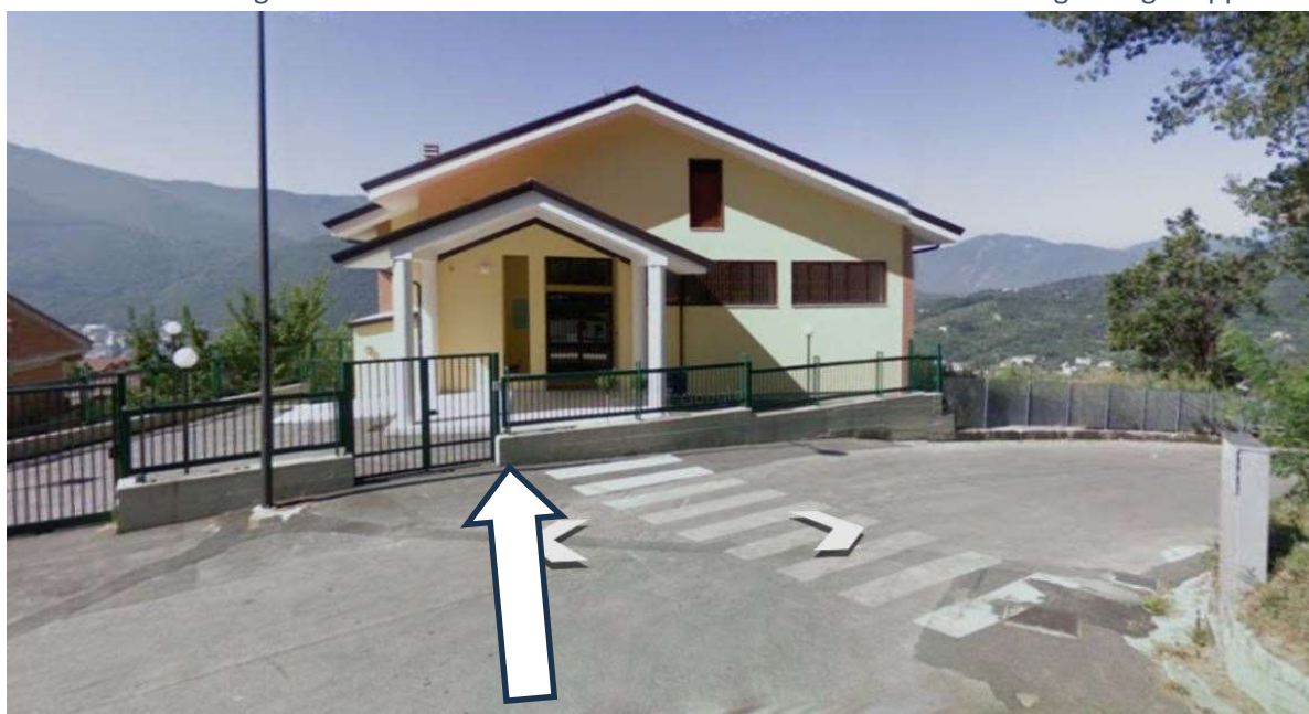
Veduta zona ingresso dalla Via Libertà lato est © Google Heart
