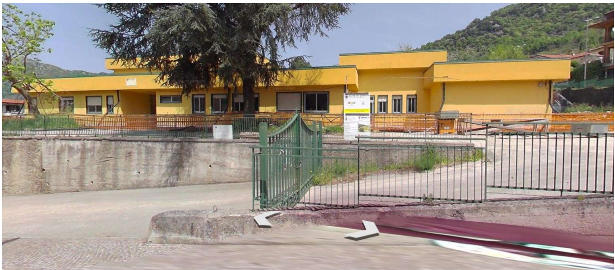
Veduta area ingresso da Via Casa Papa © Google Heart
