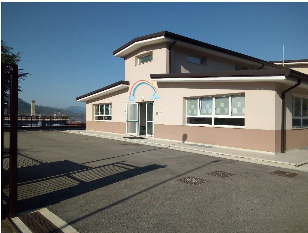
Veduta zona ingresso dal cortile interno lato est
