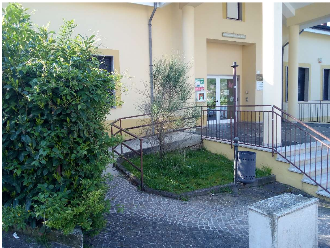
Particolare area ingresso con rampa disabili
