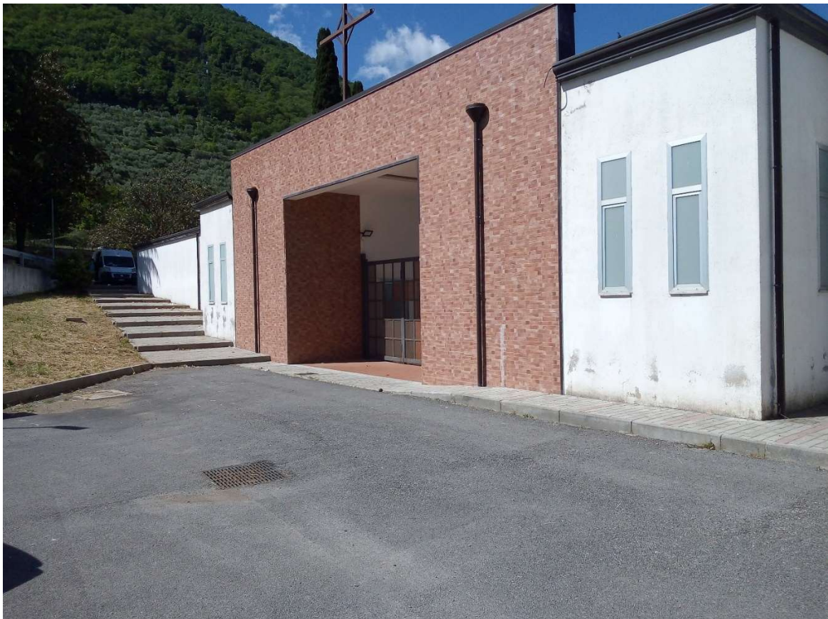
Ingresso CIMITERO CAPOLUOGO SOLOFRA II° Ampliamento
