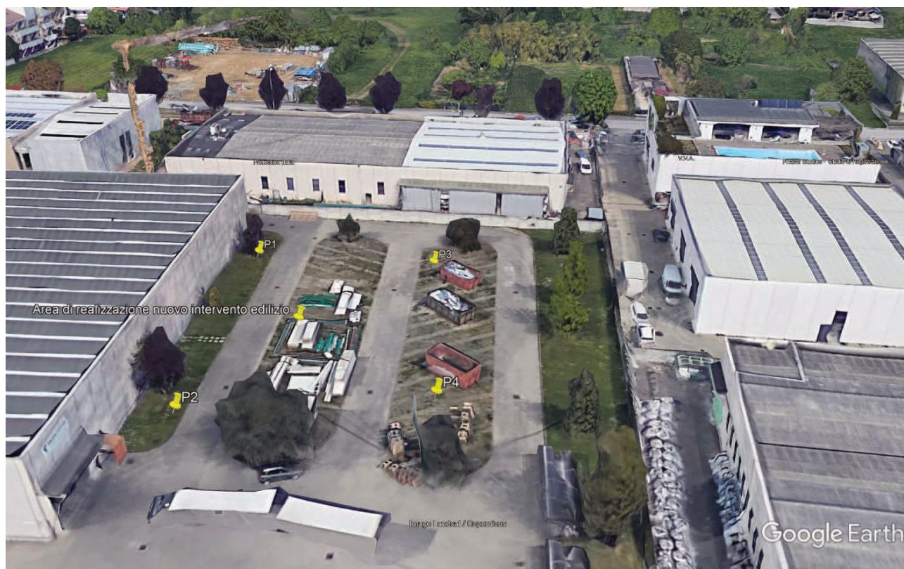
POSTAZIONE PUNTI DI INDAGINE GEOGNOSTICA "PROVE DPSH"
