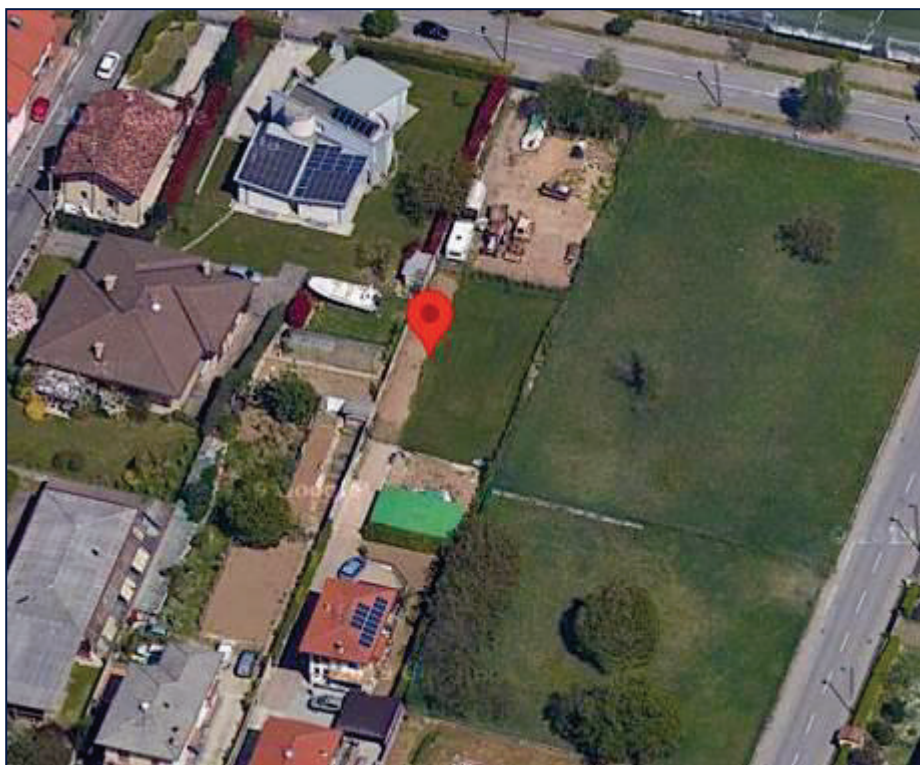
Fig. 1 – Vista aerea ambito di intervento
