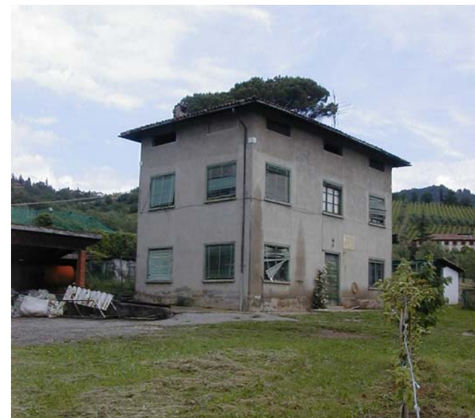
O prospetto sud-ovest
