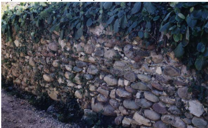
2/II muro di sostegno in pietra
