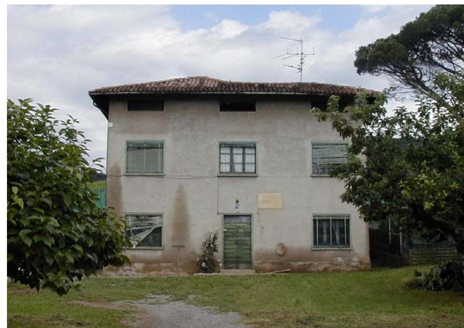
O prospetto sud-ovest
