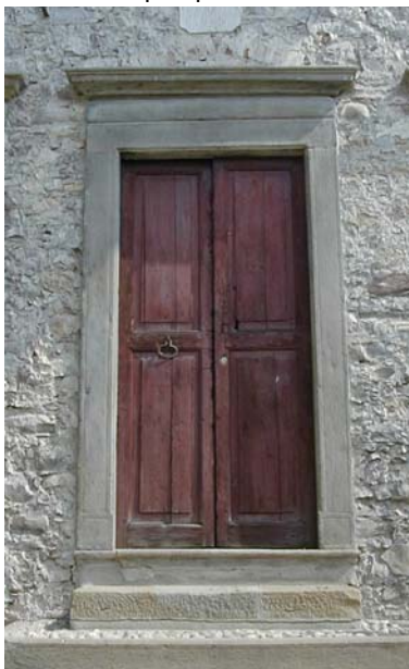
Particolare prospetto sud
