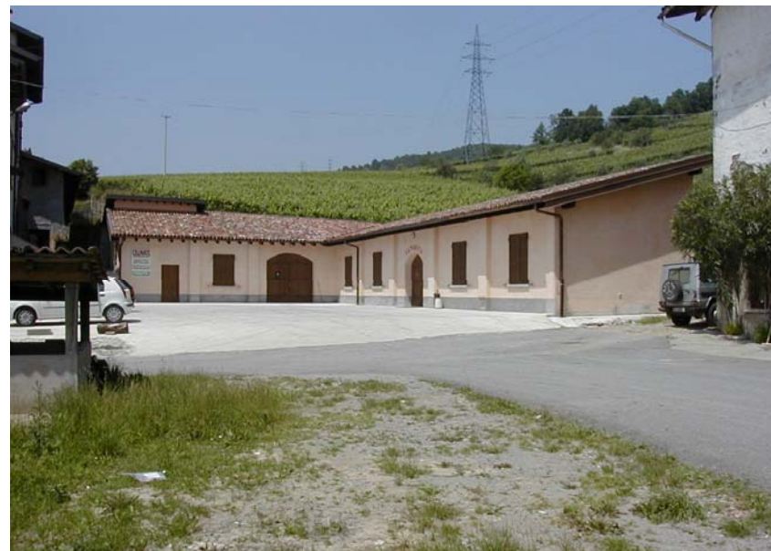
N prospetto sud –est
