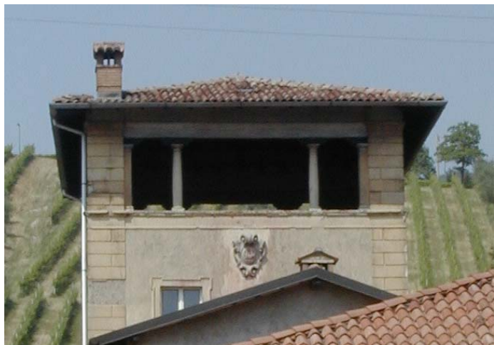
C particolare prospetto sud
