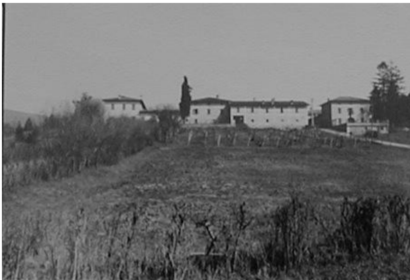
L'intero complesso visto ovest
