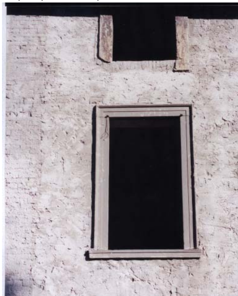
C prospetto sud, particolare
