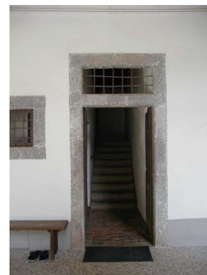
Particolare prospetto sud
