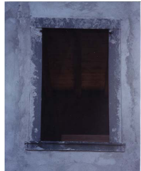
C prospetto nord, particolare primo piano
