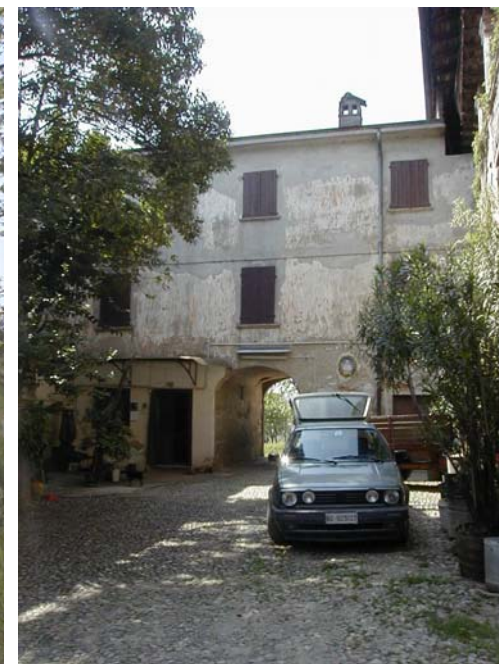
A, prospetto est interno al cortile
