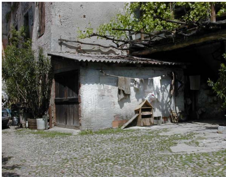
B – baracca in aderenza al prospetto est, cortile interno
