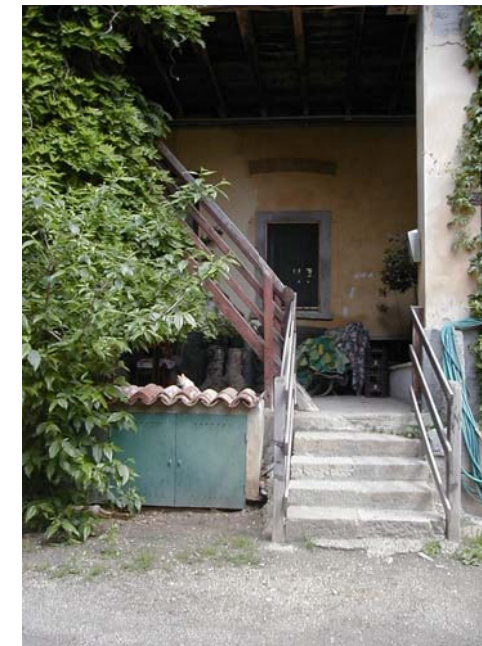
B particolare prospetto sud
