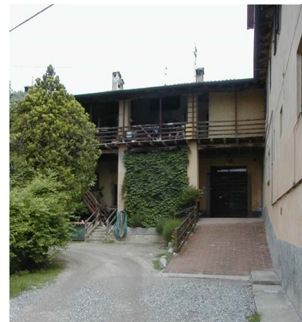
B particolare prospetto sud
