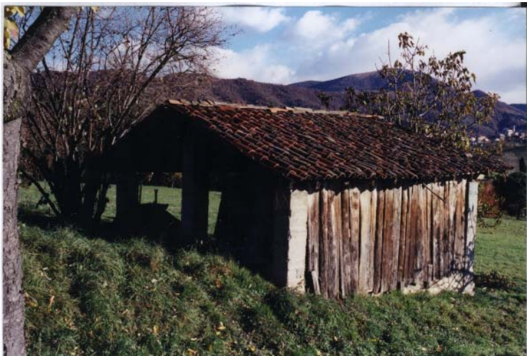
Baracche costruite nell'area di pertinenza
