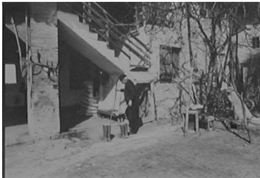
E particolare prospetto sud
