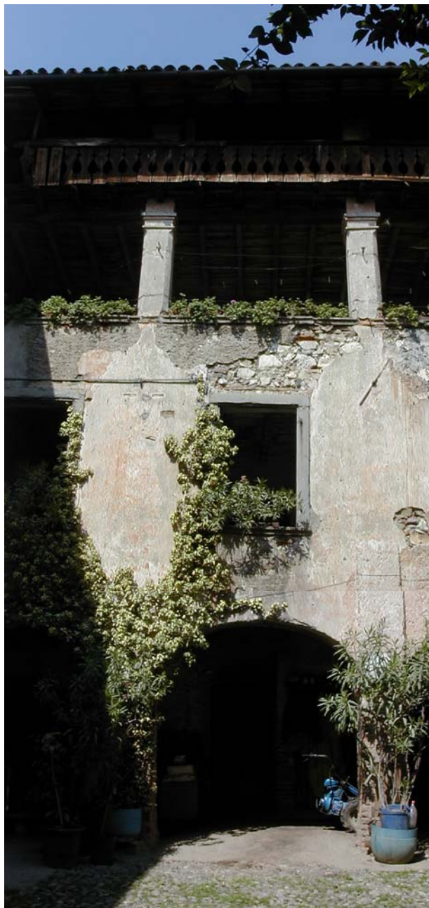
Particolare prospetto sud
