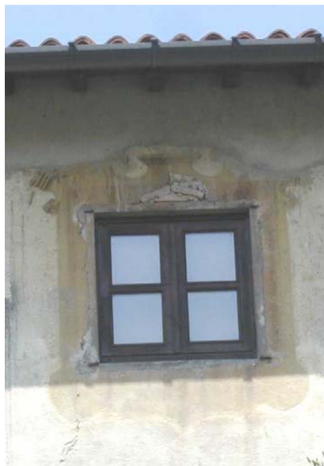
D particolare prospetto est
