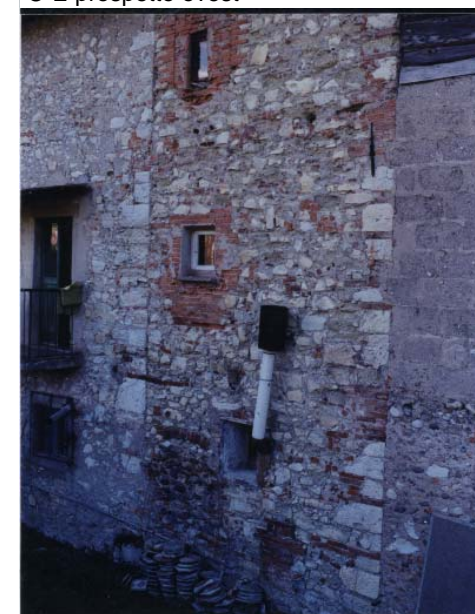
C prospetto ovest, particolare
