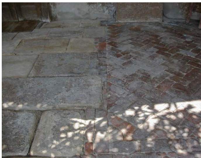
R particolare pavimentazione porticato
