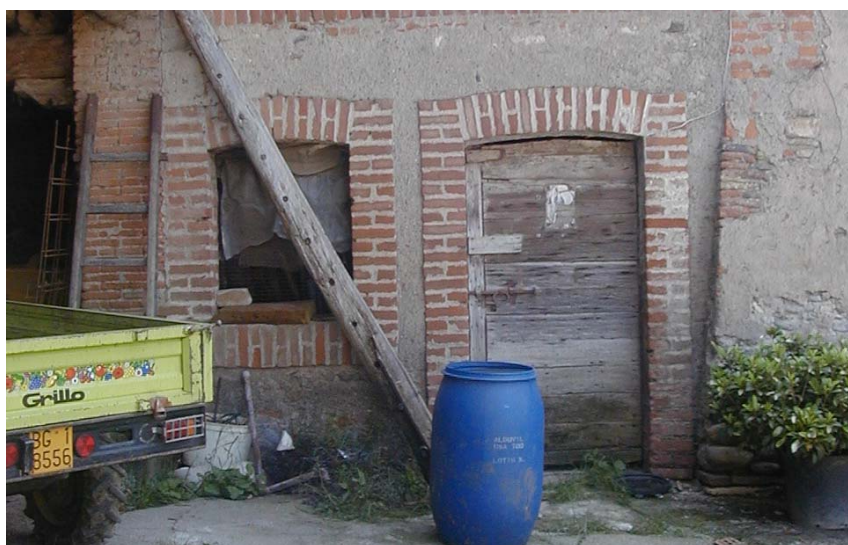
H prospetto nord, particolare
