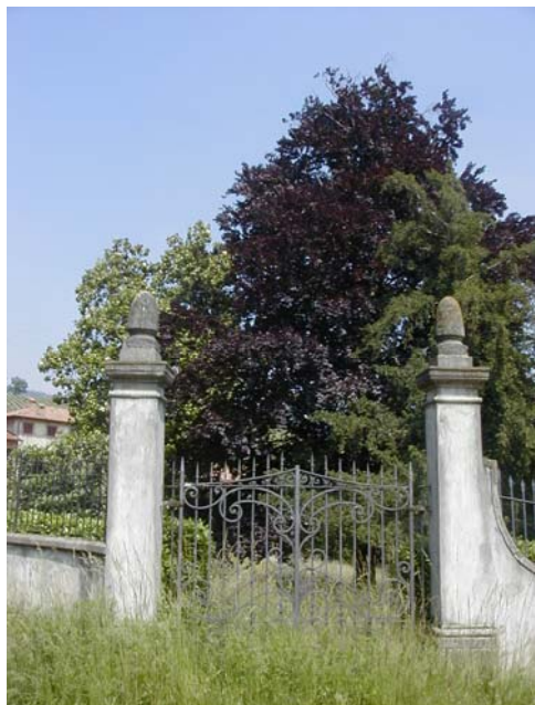
Cancello d'ingresso all'area 6/II da ovest
