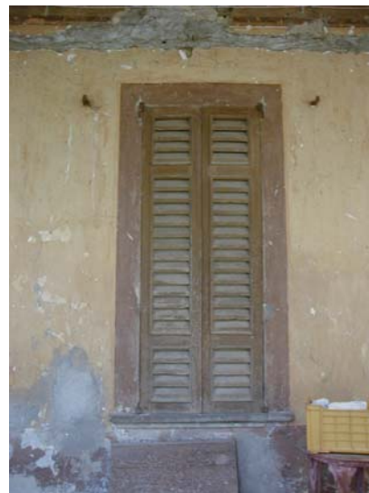
R prospetto sud, particolare
