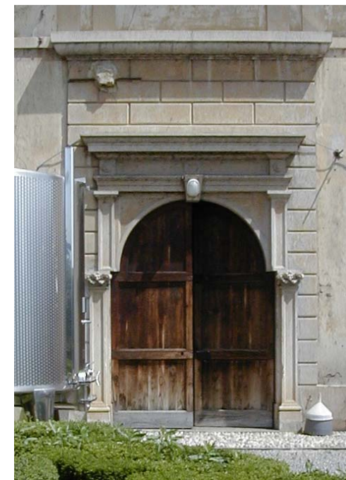
B particolare prospetto sud
