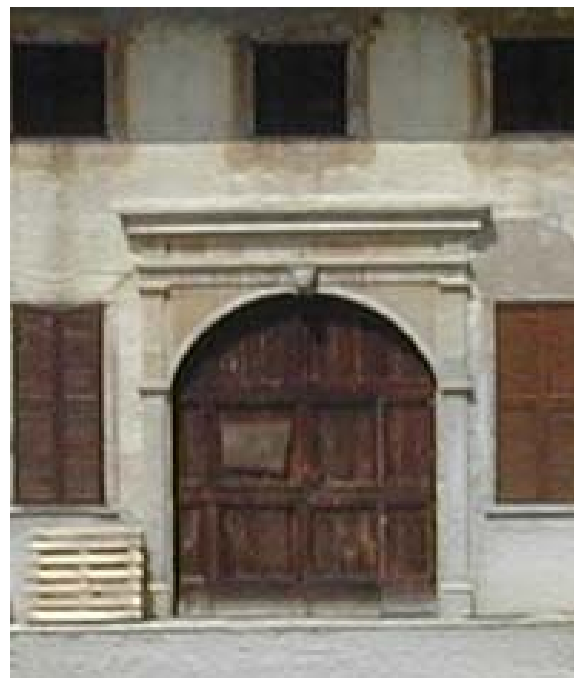
D particolare prospetto est
