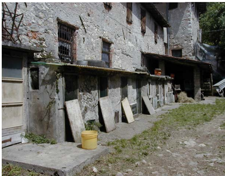
G – baracche in aderenza al prospetto est
