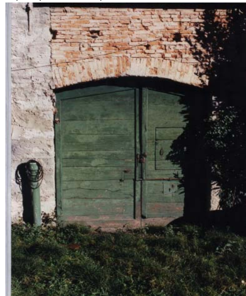
D prospetto sud, particolare
