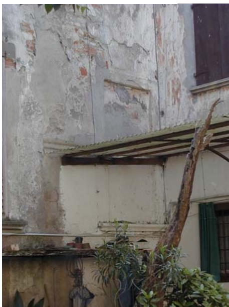
A - tettoia prospetto est, cortile interno
