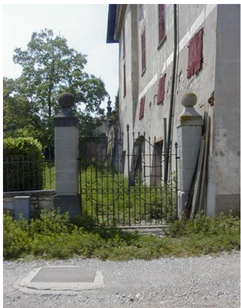
Cancello d'ingresso all'area 6/IV da est
