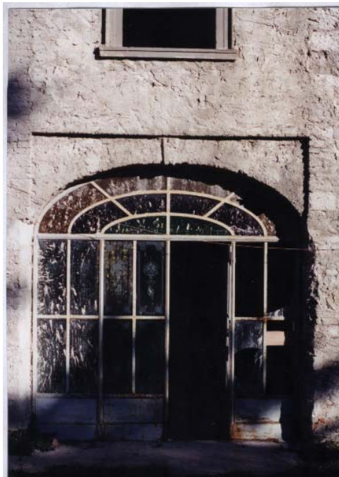
C prospetto sud, particolare
