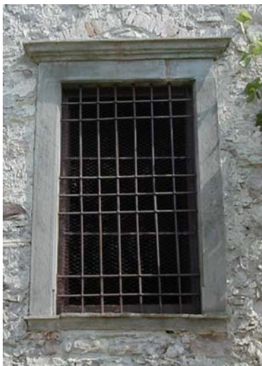
Particolare prospetto sud
