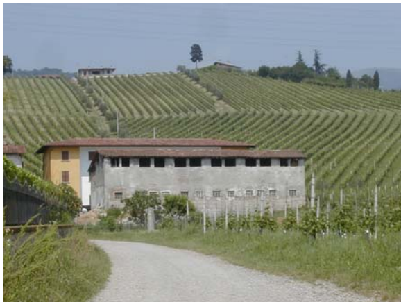
M prospetto sud
