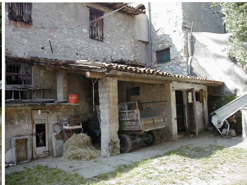
G - baracche in aderenza al prospetto est
