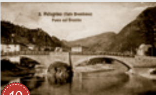
10 Ponte San Nicola (Ponte Vecchio) nella seconda metà dell'800 dopo gli interventi di rinforzo. È visibile la piccola santella centrale
