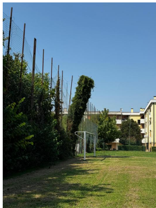
Recinzione campo sportivo lato Sud
