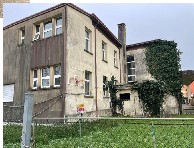
Ex Scuola Media vista da Nord
