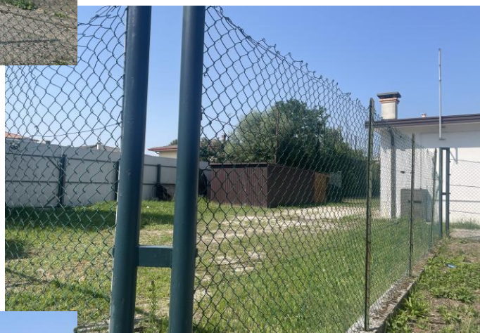
Ex Scuola Media vista da Nord
