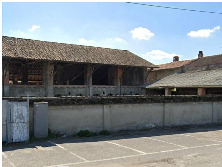
Figura 54. Fotografia della cascina agricola in via Valetta
