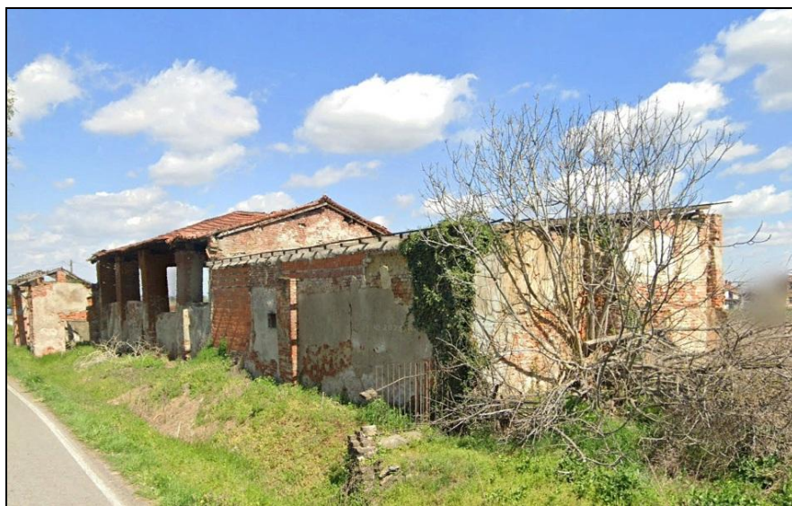
Figura 57. Fotografia del complesso edilizio di Beccalzu' oggetto di previsione di "rigenerazione urbana"
