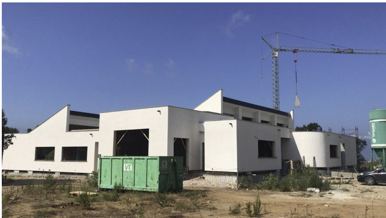
Scuola Macchiozza Lavori in corso di esecuzione
