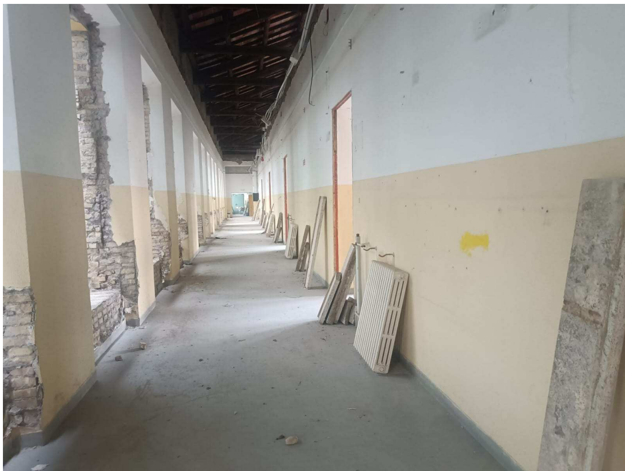
Esecuzione lavori su struttura n. 1 – via Pier Crescenzi
