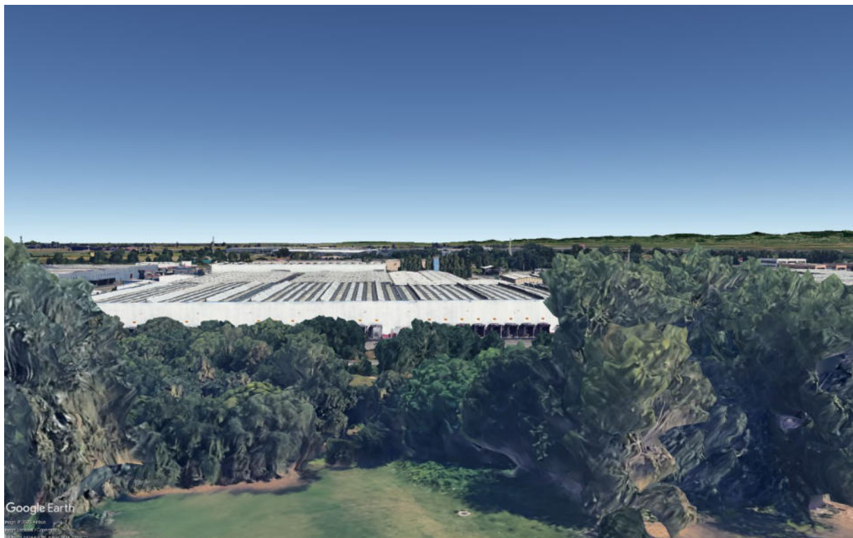
Vista dalle residenze di Via delle Rose stato di fatto
