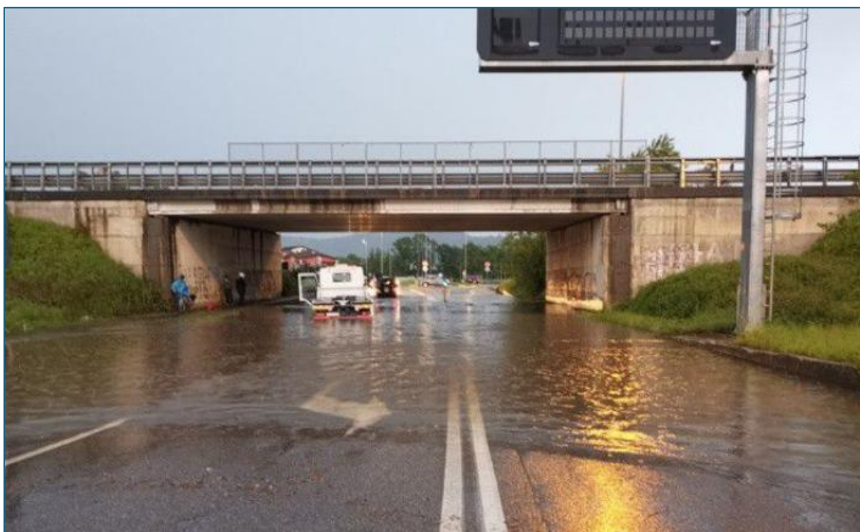
Figura 19 – Allagamento presso il sottopasso di via Garibaldi - SS 671
