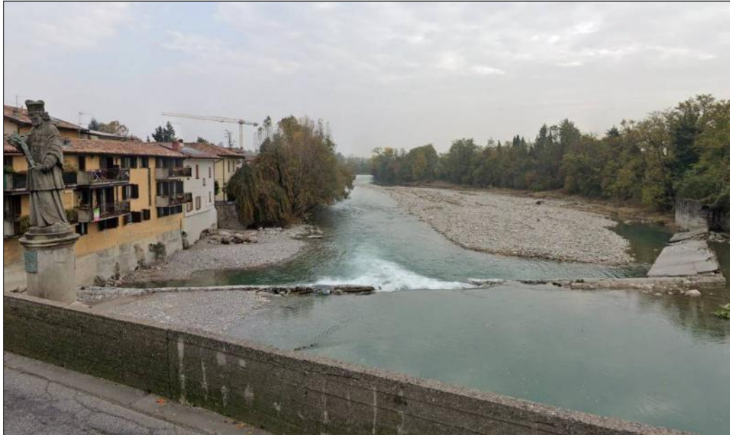
Figura 3 – Il fiume Serio a valle del ponte di Gorle
