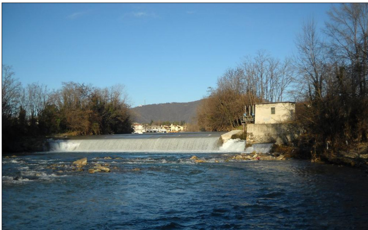
Figura 5 – Traversa di derivazione della roggia Brusaporto-Patera (ripresa da valle)
