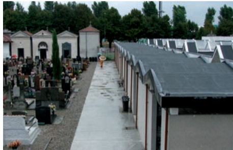
I nuovi percorsi in cemento realizzati nel cimitero
