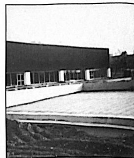
La piscina scoperta in costruzione
