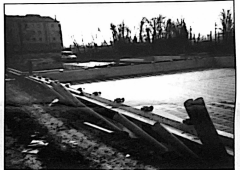
Cantiere della nuova piscina scoperta
