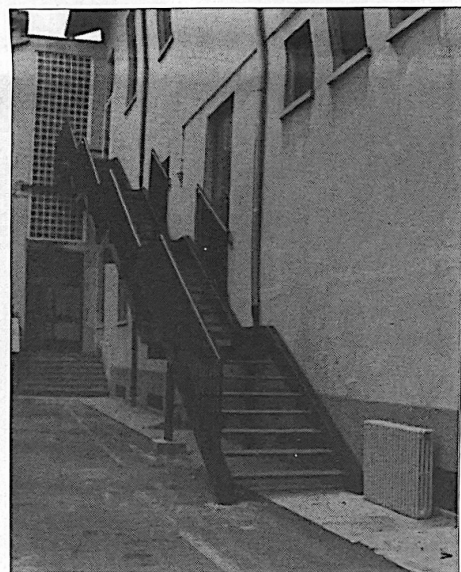
La nuova scala di sicurezza nel plesso scolastico di via Mazzini
