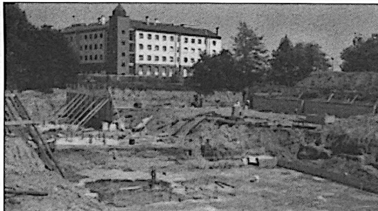
Iniziati gli scavi per la piscina
