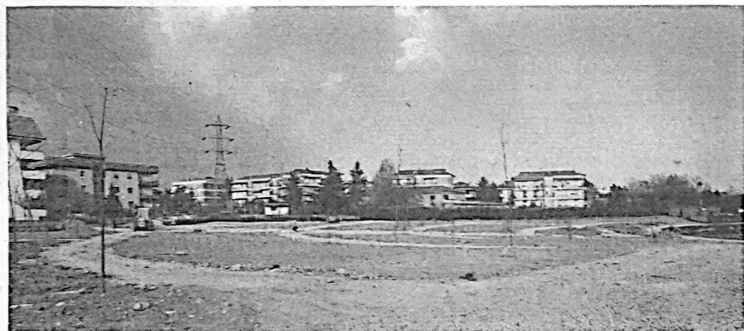
Aprile 1990: la fase terminale dei lavori
