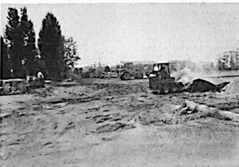
Nuova strada di collegamento tra il campo sportivo e via Mazzarello.
