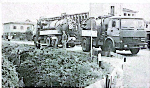
Lavori di disinquinamento della roggia Bora
