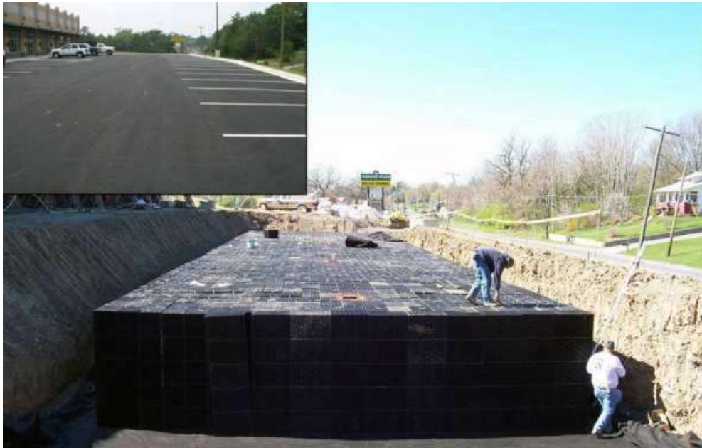
Figura 9-1- Cella modulare in materiale plastico in fase di montaggio
