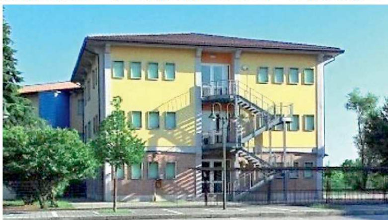
Le scuole medie Mantegna dove il giovane si è tolto la vita lasciandosi precipitare dall'ultimo piano
