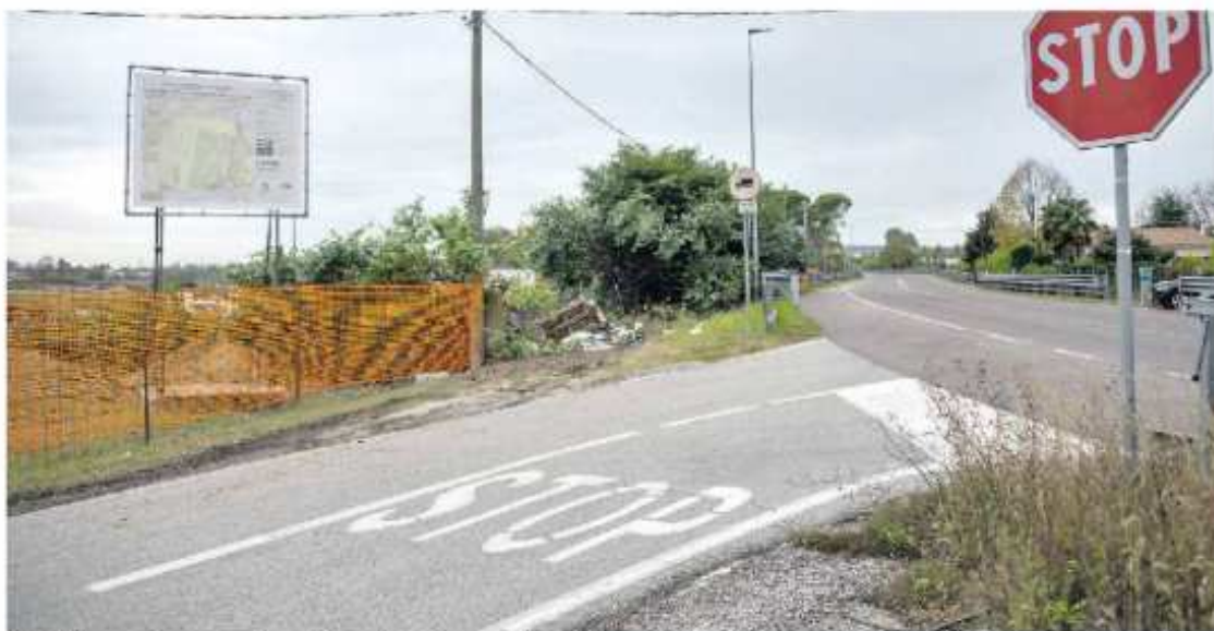
L'OPERA L'incrocio accanto al quale è prevista la costruzione del nuovo polo logistico di Arino di Dolo
