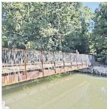
LA PASSERELLA La struttura che sostituisce quella usurata
