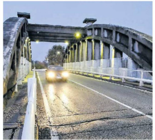
CAVALCAVIA Il viadotto di via Giustizia: lavori prorogati fino al 16 ottobre con tre chiusure notturne totali, anche i bus di Actv
