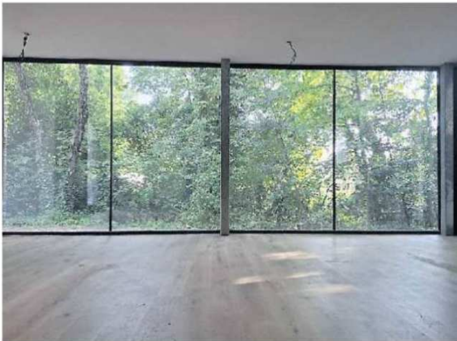
ULTIMI RITOCCHI Lavori in fase conclusiva, da ultimare gli arredi
