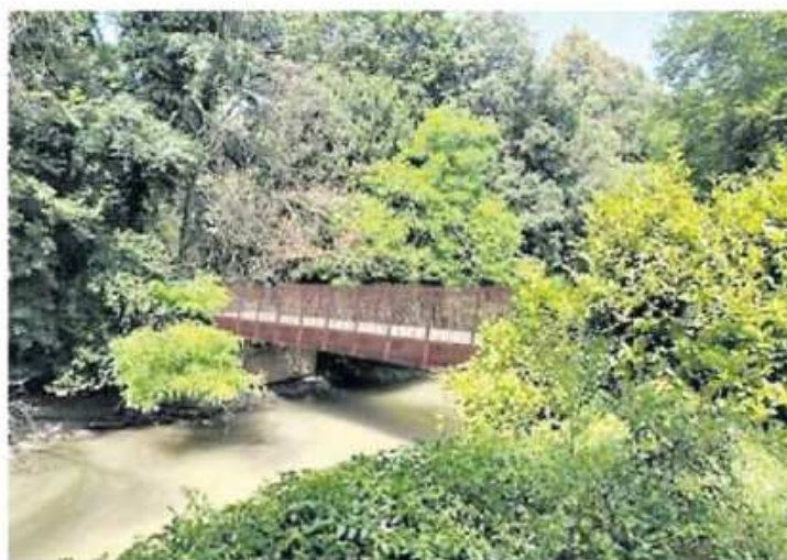
I LAVORI Conclusione entro l'estate per sostituire la struttura in legno con una nuova in acciaio
