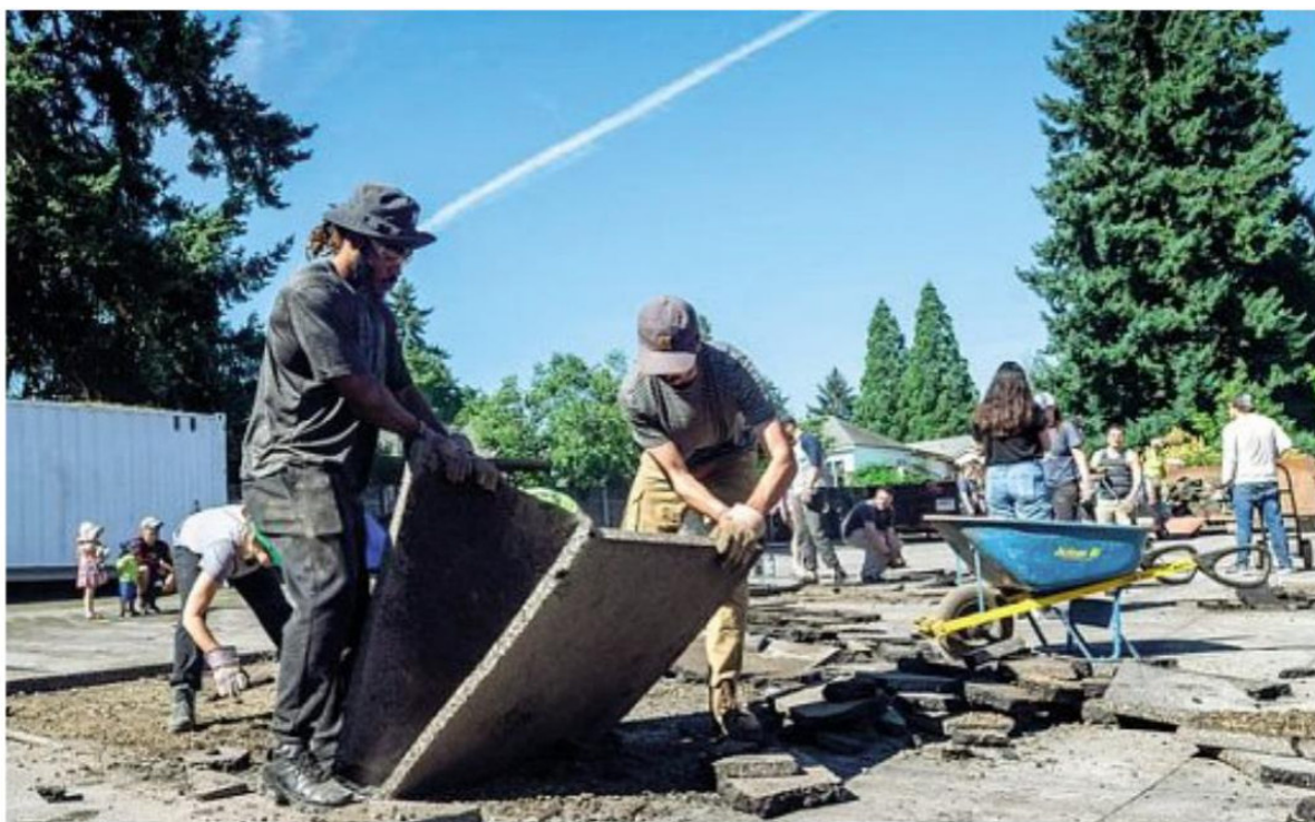
Via il cemento Squadre di giovani in azione per rimuovere in una piazza gli elementi in cemento e introdurre alberi, piante e altri elementi naturali
