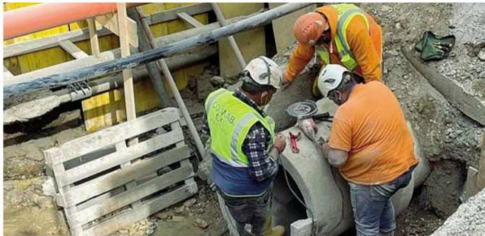
La manutenzione Un cantiere sulla rete idrica. I gestori spendono in Veneto milioni di euro all'anno per migliorare le condutture
