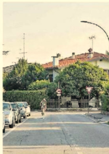
CANTIERI Viale Treviso a Mirano
