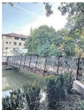
L'OPERA Il nuovo ponte sul Muson riaprirà sabato
