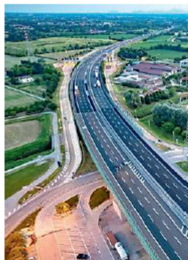
Tratto del passante di Mestre
