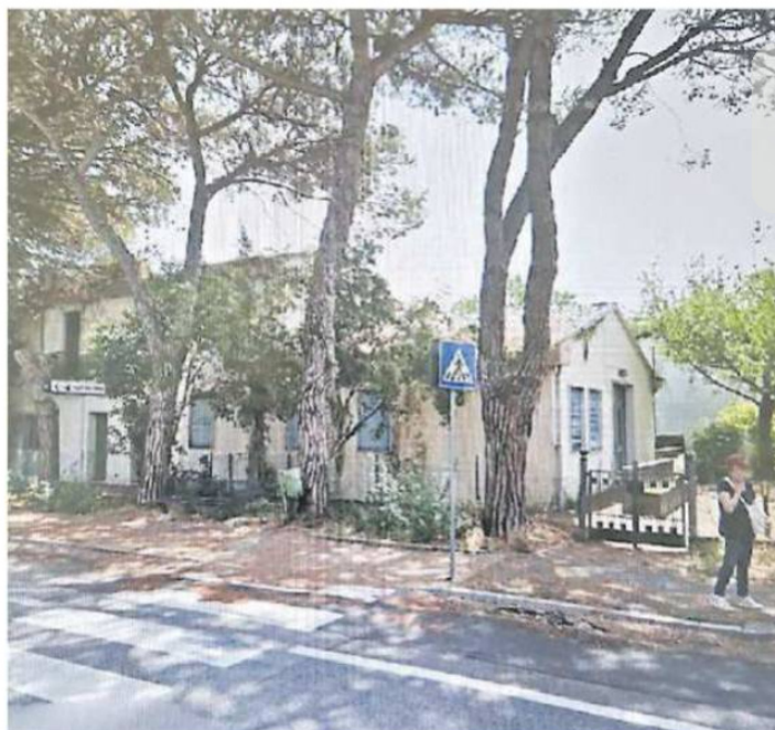
DA ABBATTERE L'edificio, vecchia sede sanitaria in disuso, che verrà demolito per fare spazio al nuovo SerD
