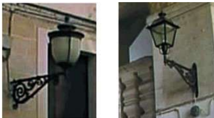
Sistema di illuminazione a mensola in ghisa con corpo illuminante a lanterna portato
