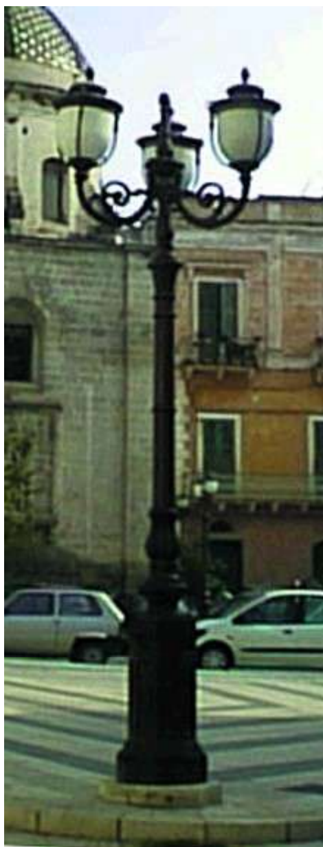
Sistema di illuminazione su palo in ghisa con cime a uno o più corpi illuminanti a portati
