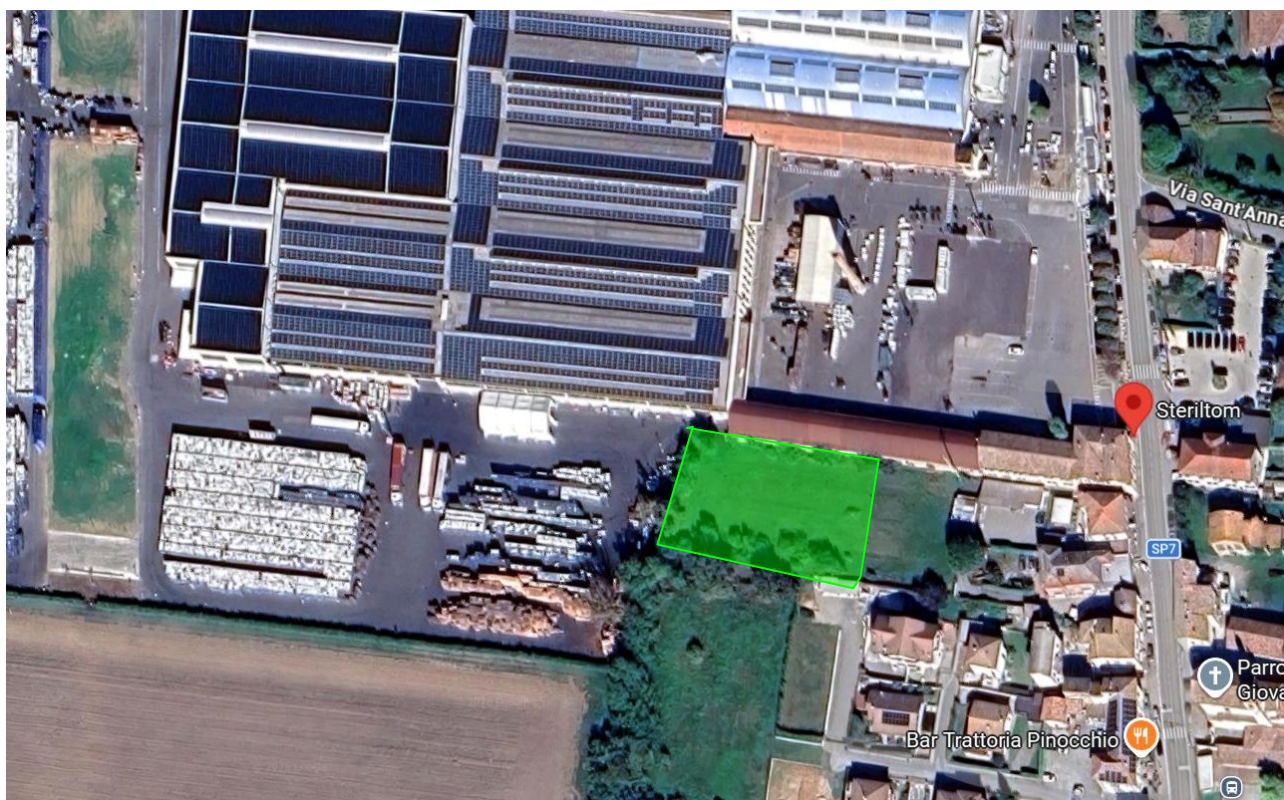
Figura 2 – Vista della Steriltom dall'alto con indicazione del posizionamento delle nuove baie di carico
