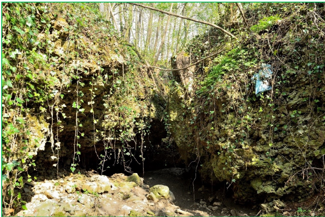
Figura 35 - Ostruzione puntuale dell'alveo in località Cà dell'Agro dovuta al crollo di ambedue le sponde
