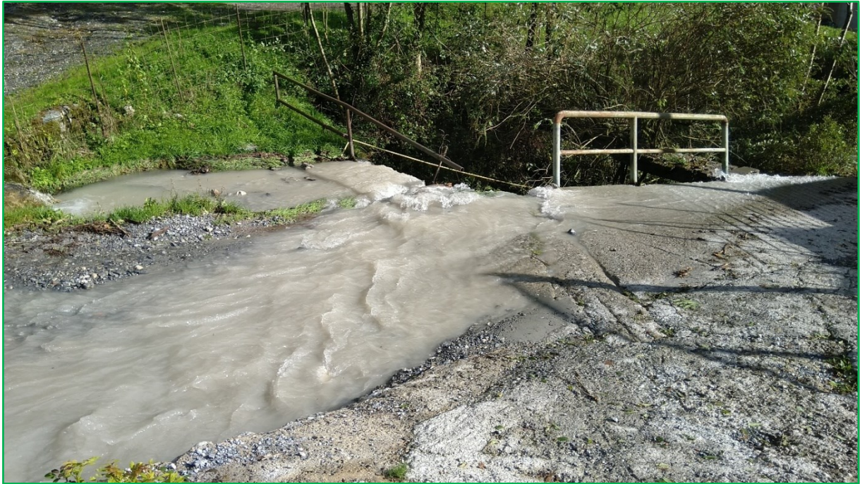
Figura 13 - Esondazione del Torrente Concozzola sulla strada in corrispondenza del guado a monte degli Opifici durante l'evento di piena di inizio ottobre 2020
