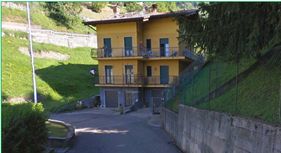
Figura 49 - Fabbricato residenziale posto praticamente nell'alveo del Torrente Togna (ramo della Valle di San Giacomo)
