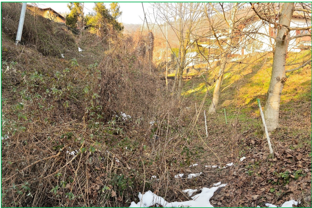
Figura 42 - Condizioni medie del tratto di BG123.03 compreso tra Via Pino di Sotto e Via Cervino
