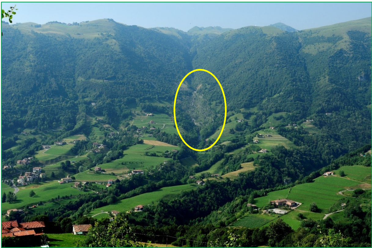
Figura 59 - Panoramica sulla Val Groaro da Peia, con evidenziato in giallo il ghiaione principale
