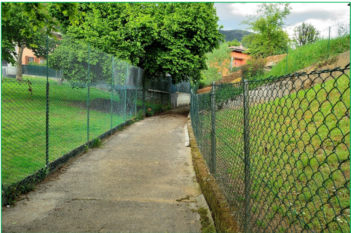
Figura 34 - Tratto tombinato di Torrente Re racchiuso fra proprietà private parallelo a Via A. Fantoni
