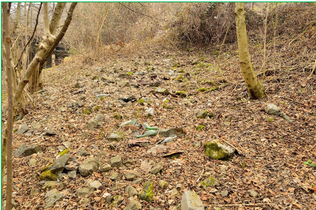
Figura 63 - Cospicui accumuli detritici nel tratto medio della valletta, in località Ruch, che indicano la forte propensione al trasporto solido e l'elevata disponibilità di materiale mobilizzabile fino al fondovalle
