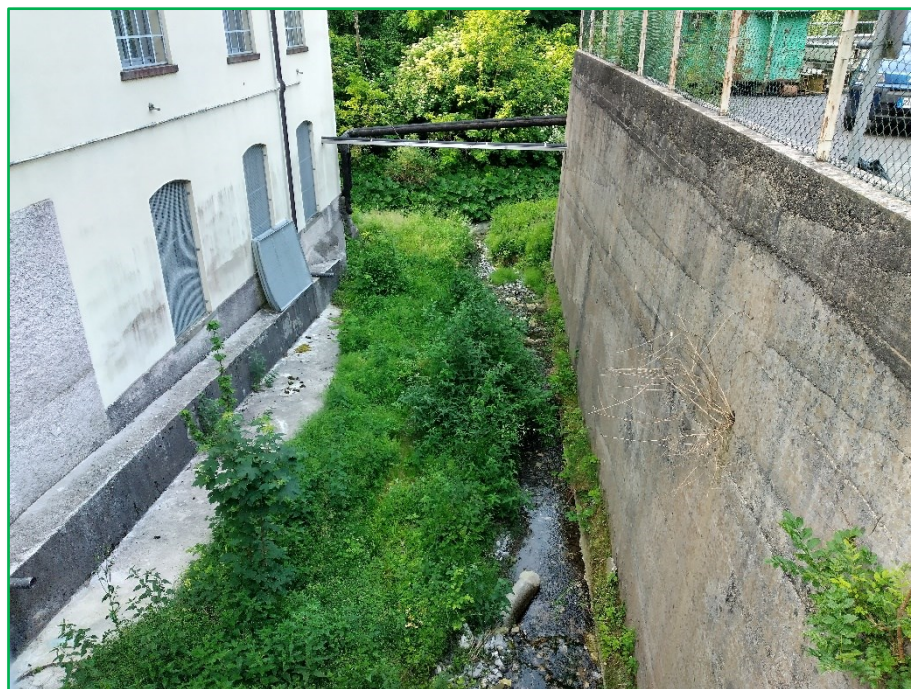
Figura 58 - Zona di confluenza del Torrente Tinella (freccia gialla – foto in basso) nel Torrente Romna (freccia rossa) in località Opifici; L'alveo del Romna in questo punto è molto stretto, essendo incassato tra gli edifici e i relativi muri sulla sponda destra ed il versante montuoso molto ripido sulla sponda sinistra (riquadro nero)
