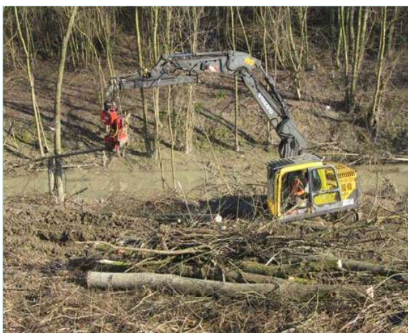
Figura 3 - La vegetazione dovrà essere tagliata a raso lasciando le ceppaie che devono continuare ad assolvere
