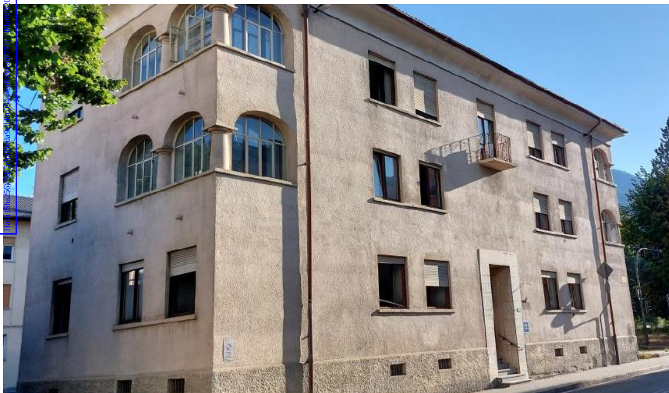
Vista angolo sud-ovest dell'edificio.
