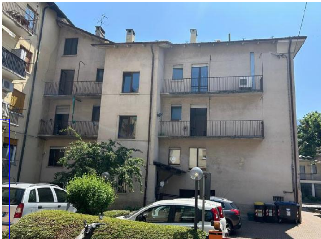
Vista facciata nord, interna dell'edificio.
