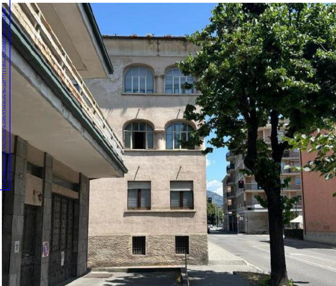
Vista facciata ovest.
