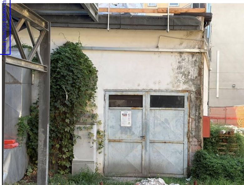
Particolare lato nord dell'edificio.
