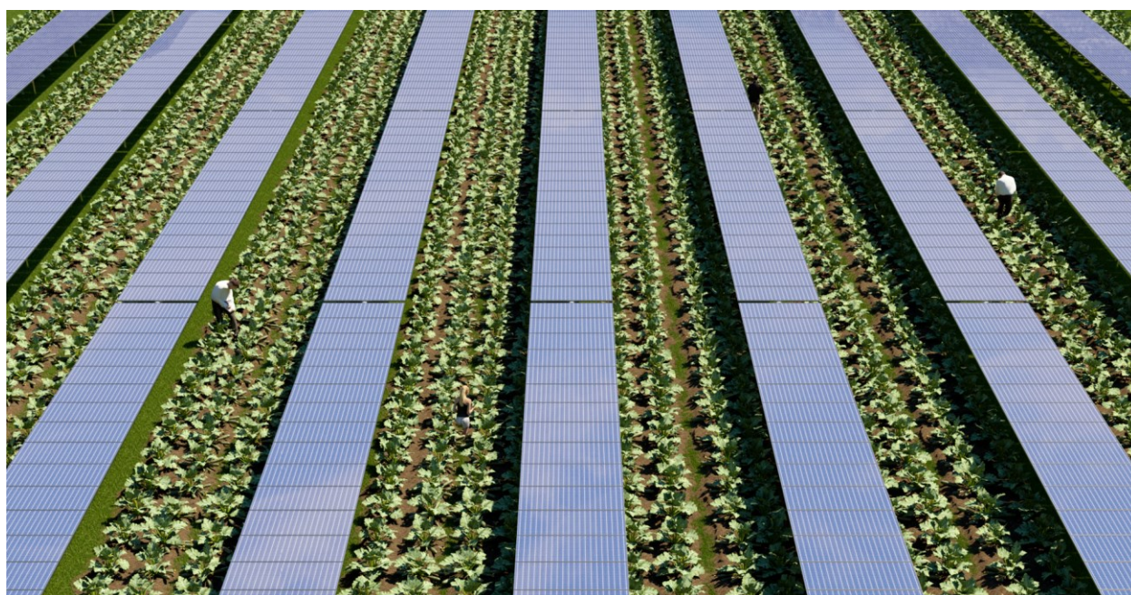
Figura 11 - Esempio di impianto agrivoltaico
