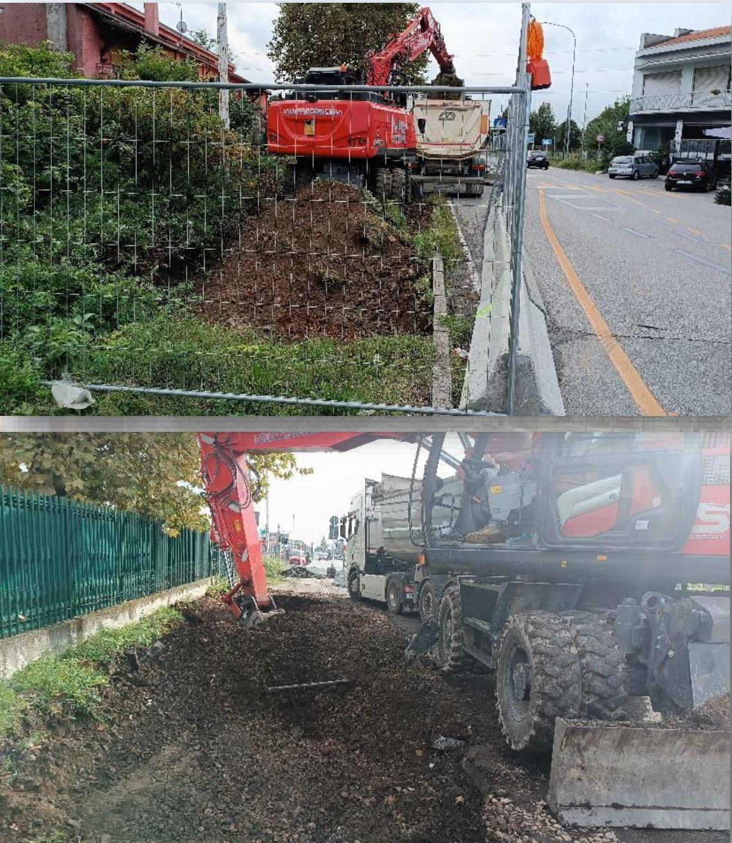
La realizzazione della Metrotranvia ha richiesto l'attuazione di **Progetti Operativi di Bonifica (POB)** (ai sensi dell'art. 242-bis del D.Lgs. 152/2006) per la rimozione di terreni e riporti non conformi, riscontrati in alcuni punti del tracciato.
