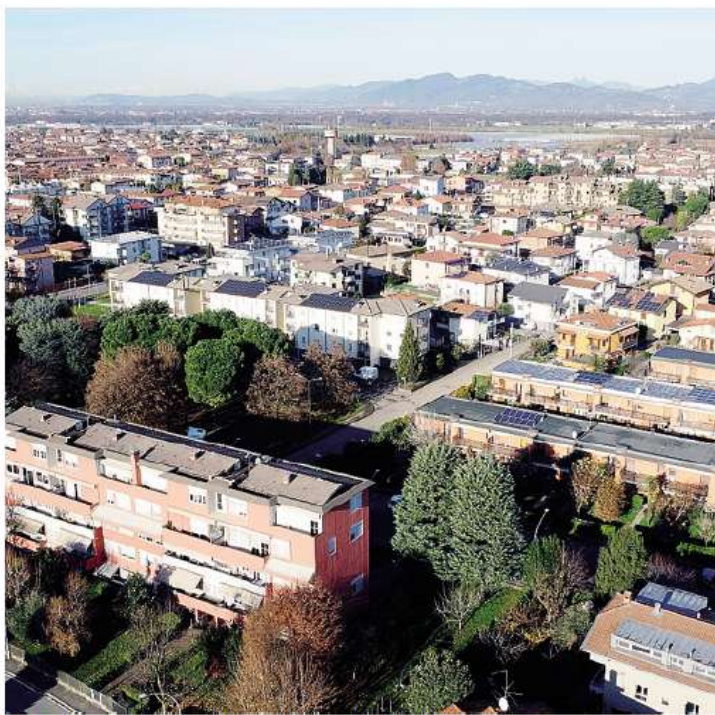
Nell'Ambito di Dalmine cresce la richiesta di case a fronte di oltre 11mila immobili sfitti FOTO MARAVIGLIA
