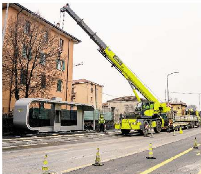
La posa di una pensilina lungo il tracciato dell'e-brt a Laillio
