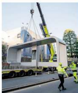
I lavori in via del Caniana
