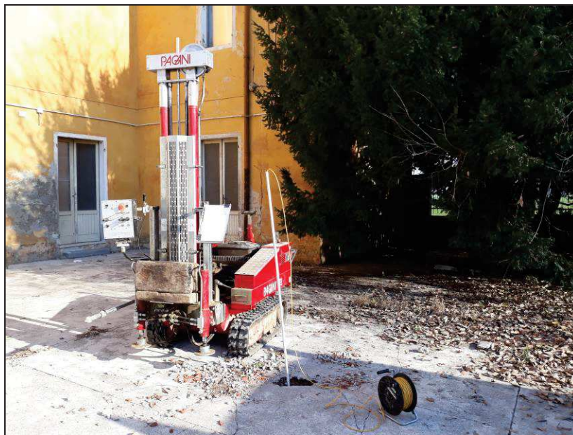
Figura 7: tubo piezometrico e rilevazione freaticometrica in corrispondenza della prova P2, comune di Crema (CR), via Garzide 1, il 24/11/2020
