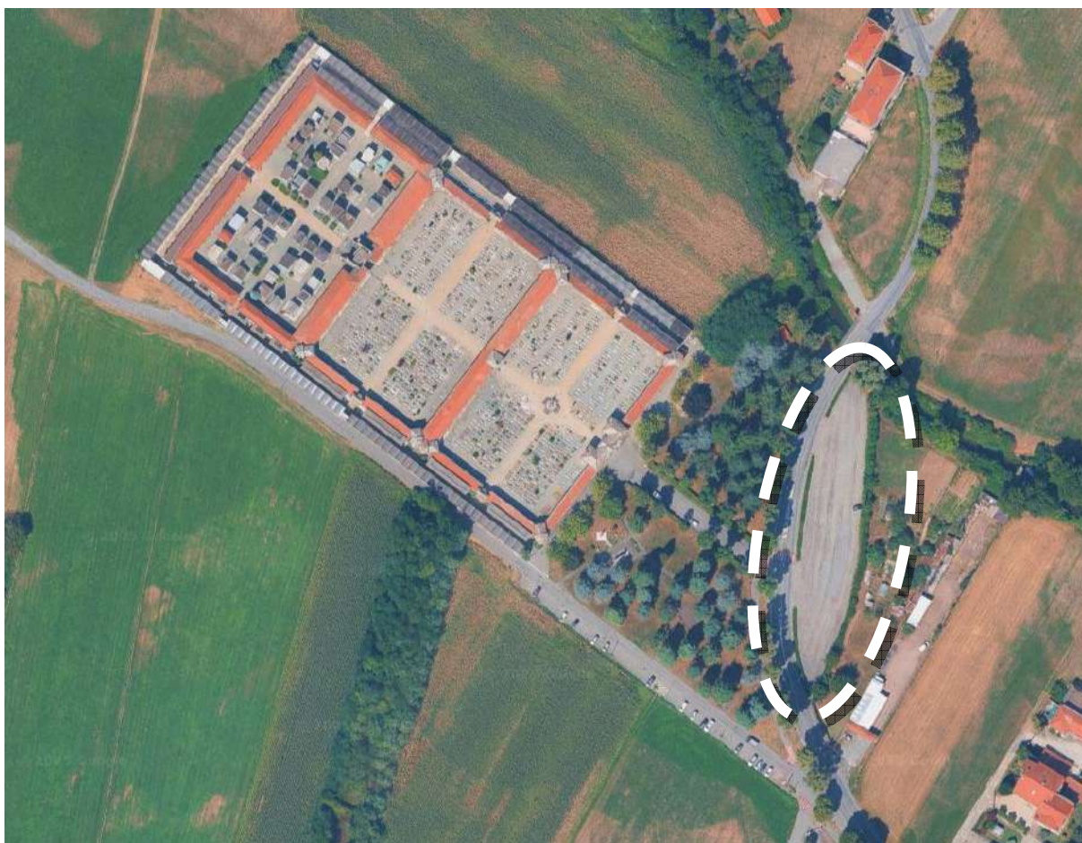
Localizzazione del parcheggio asfaltato su foto aerea.
