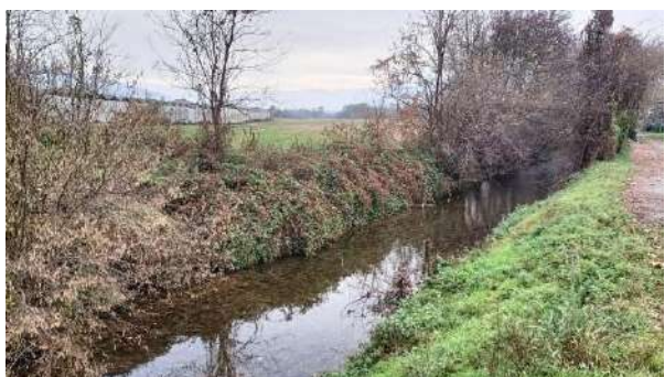
Foto 6 (a monte del ponte della SP22)
